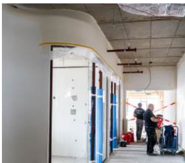
Abaissements de plafond
